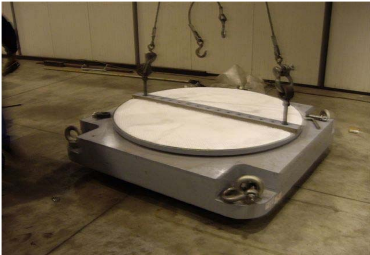
Disassemblaggio appoggio Disassembled bearing
